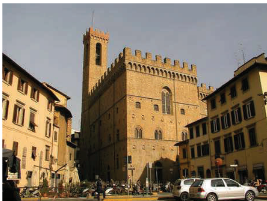
Palazzo del Bargello (1234/1285-1346), Florența
