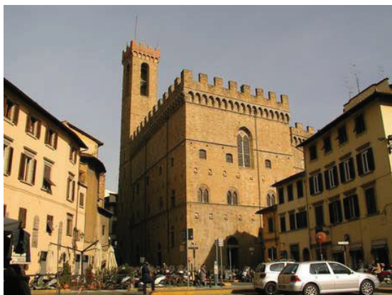
Palazzo del Bargello (1234/1285-1346), Florența
