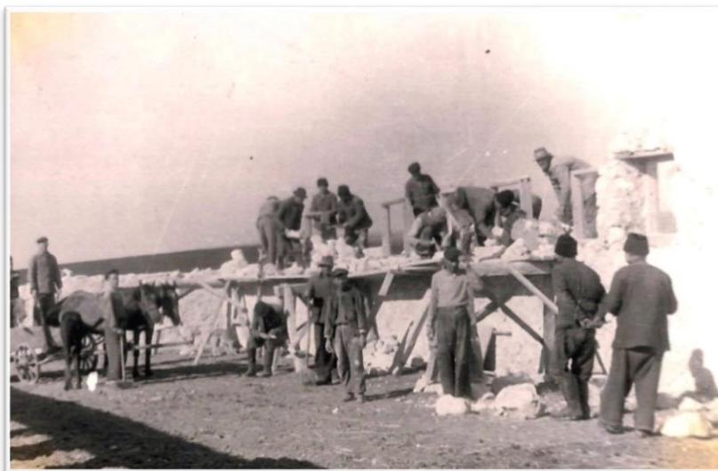
Figura 5. Construcția fermei din colhozul Kalinin, satul Sofia, raionul Bălți.
