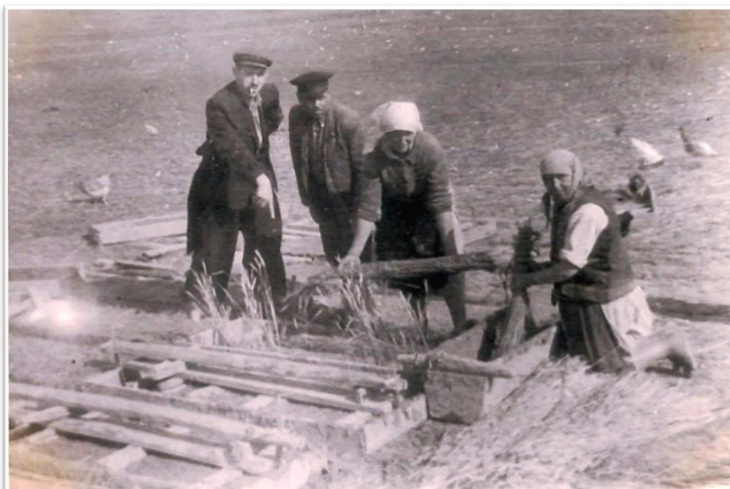
Figura 6. Confecționarea chirpicilor din lut în colhozul A. Jdanov, satul Pânzareni, raionul Fălești.
