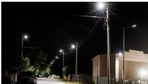
Fig. 1. Iluminare stradală cu energie electrică
