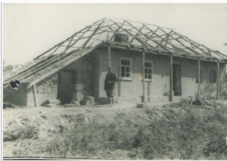
Figura 3. Casă în proces de construcție, satul Jura, raionul Râbnița, 1949.
