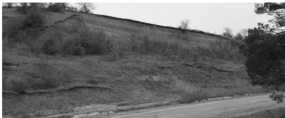
**Рис. 1.** Откос выемки, подвергнутый оползневым процессам на одном из участков автомобильной дороги М21 (Кишинэу-Дубэсарь-Полтава). Март 2016.
