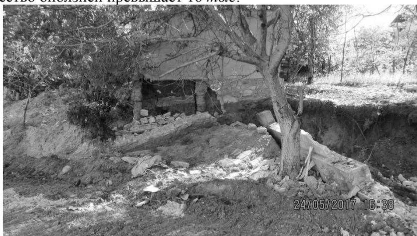
**Рис. 1** Разрушение жилого дома в г. Кодру в результате оползневых подвижек.
