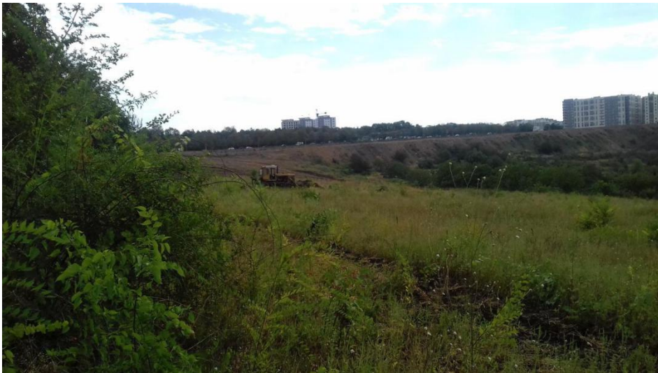
Fig. 3: Lucrări tehnice de înlăturare a orizonturilor superioare ale solului prin nivelare.
