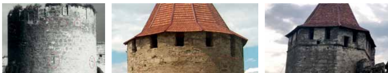
Fig. 15. Tighina, turnul de nord-vest, golul de ieșire la galeria pândantă și cuiburile de la console (Foto: Daniel Siegfriedsohn, 1918-1944, Internet) (a); turnul de sud-est, gol de ieșire la galerie și cuiburi de la console (Foto: Nesterov, 2008) (b); turnul de nord-est (octogonal), gol de ieșire la galeria pândantă (Foto: Nesterov, 2010) (c)
