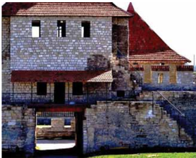
Fig. 12. Intrarea în moschee prin coborâre pe 4 trepte de pe drumul de strajă (sursa: Internet) (a) și Turnul intrării; căptușirea zidăriei din interior cu alungirea pe o porțiune nouă spre curte, foto anii 2000 (Sursa: Internet) (b)
