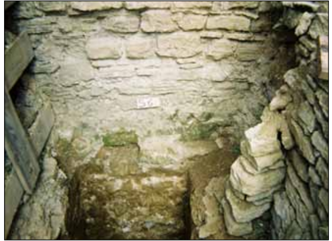
Fig. 10. Latura de sud a zidului de incintă. Fundația foișorului
