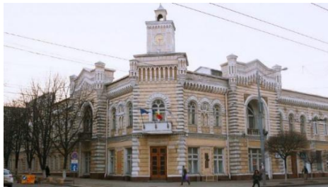
Clădirea Dumei Orășenești (1901-1903)
