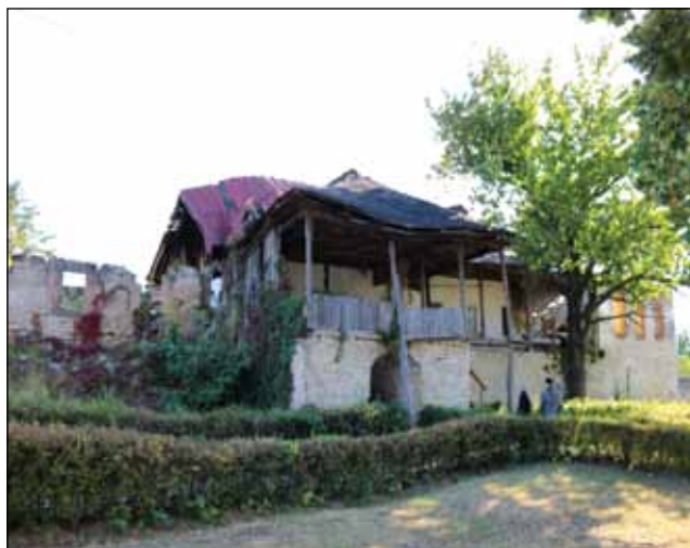
Fig. 2. Aspectul Casei Stăreției la data începerii lucrărilor Fig.2. The appearance of the Abbot's House at the beginning of the works
