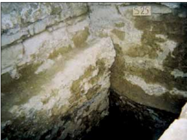
Fig. 7. Casa Stăreției. S 25. Adosarea zidului de incintă față de zidul Casei
