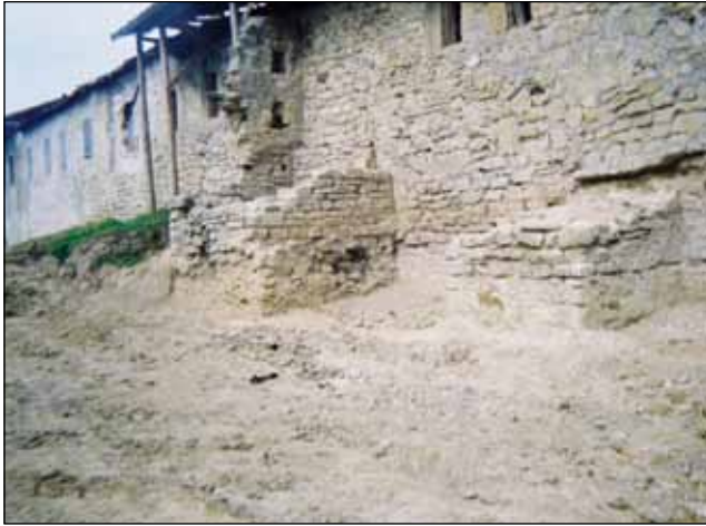
Fig. 9. Latura de sud a zidului de incintă și al casei; turnul (foișorul) și un contrafort
